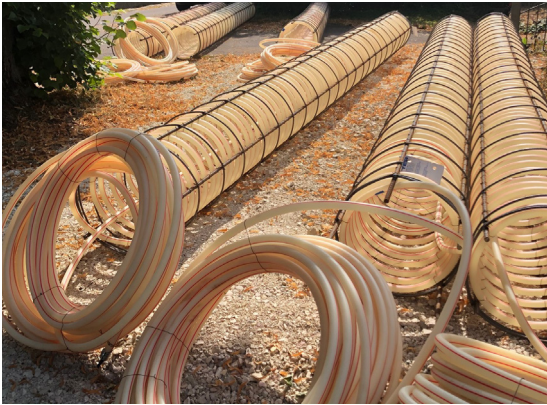
LOTTER GEOSONDEN bereit für den Einbau.
