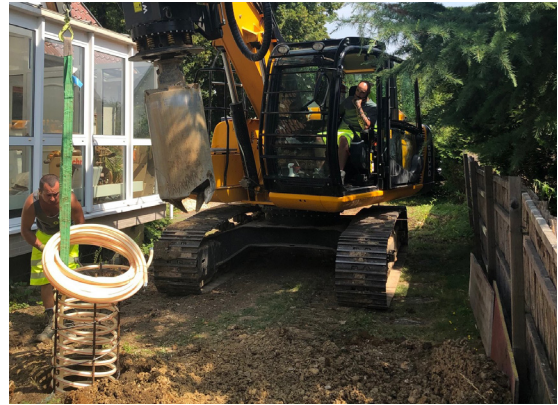
LOTTER GEOSONDE wird ins Erdreich eingebracht.
