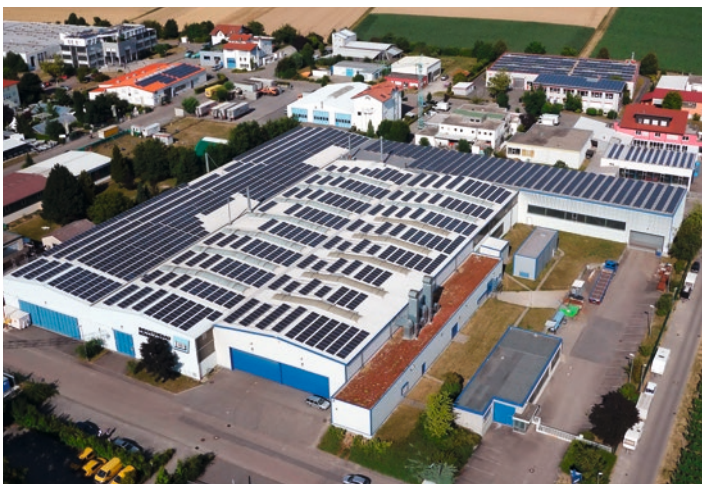
Auf rund 6.000 m 2 reiht sich Kollektor an Kollektor.
