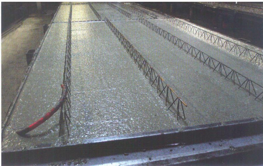
Betonierte thermoaktive Elementdecke
