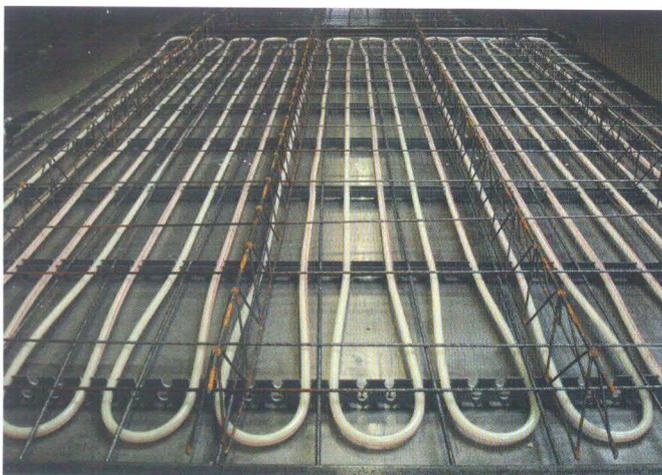
Fertig vorbereitete Paletten mit Rohrregister und Bewehrung
