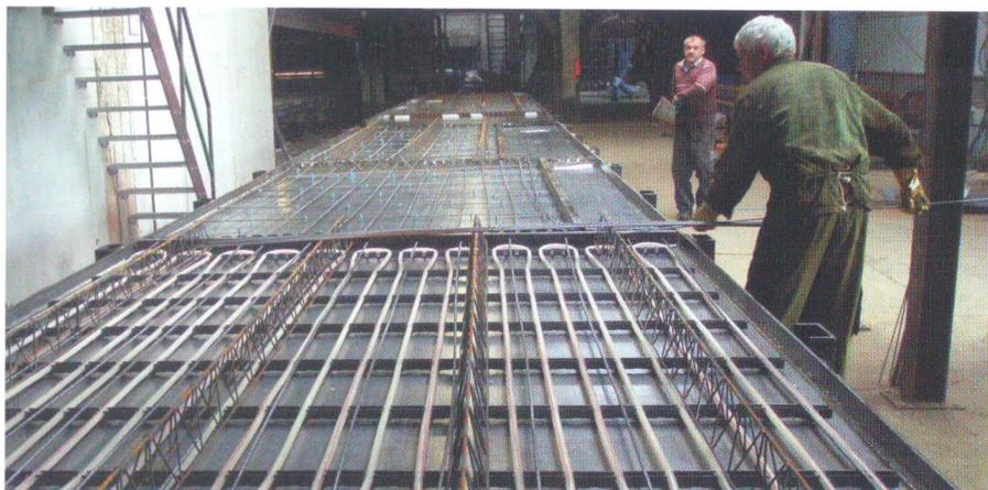
Nach dem Herstellen der Rohrregister wird die Bewehrung eingebaut.
